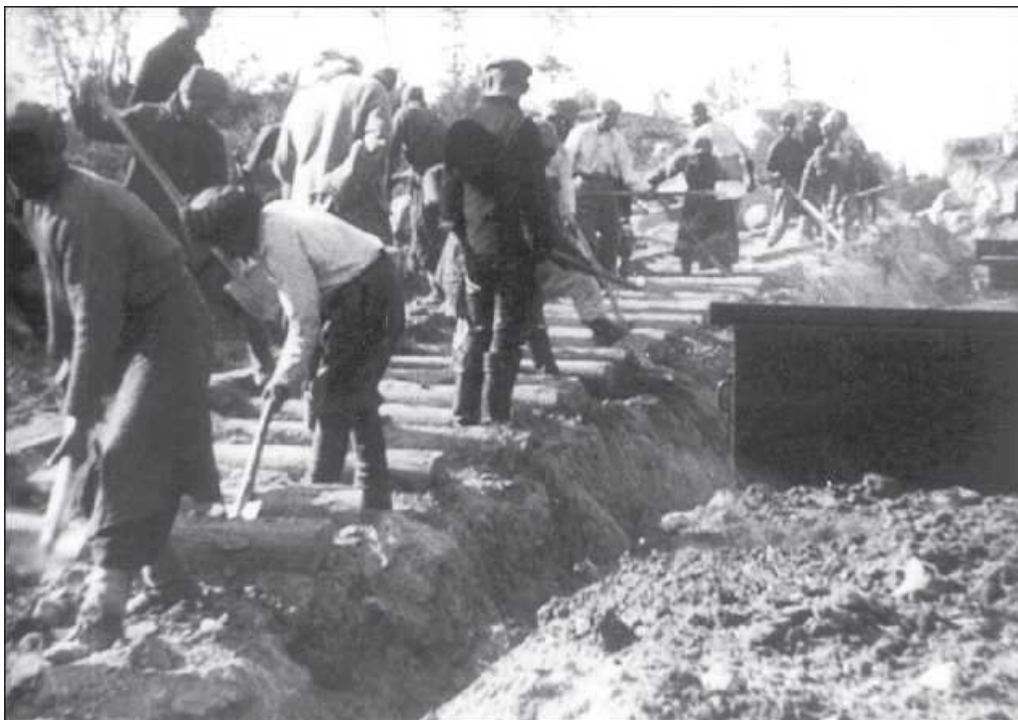
Соловецкий концлагерь. Строительство узкоколейки
