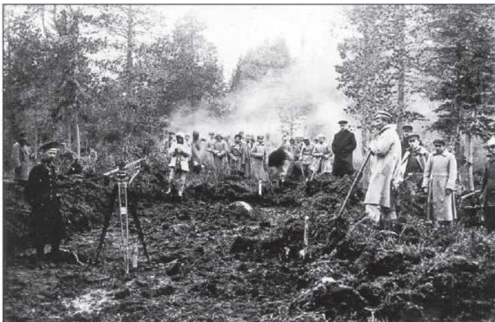
Соловецкий концлагерь. Строительство узкоколейки
