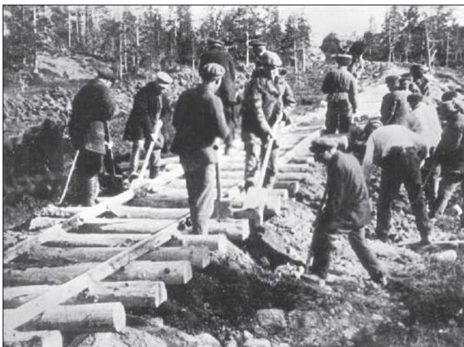
Соловецкий концлагерь. Строительство узкоколейки
