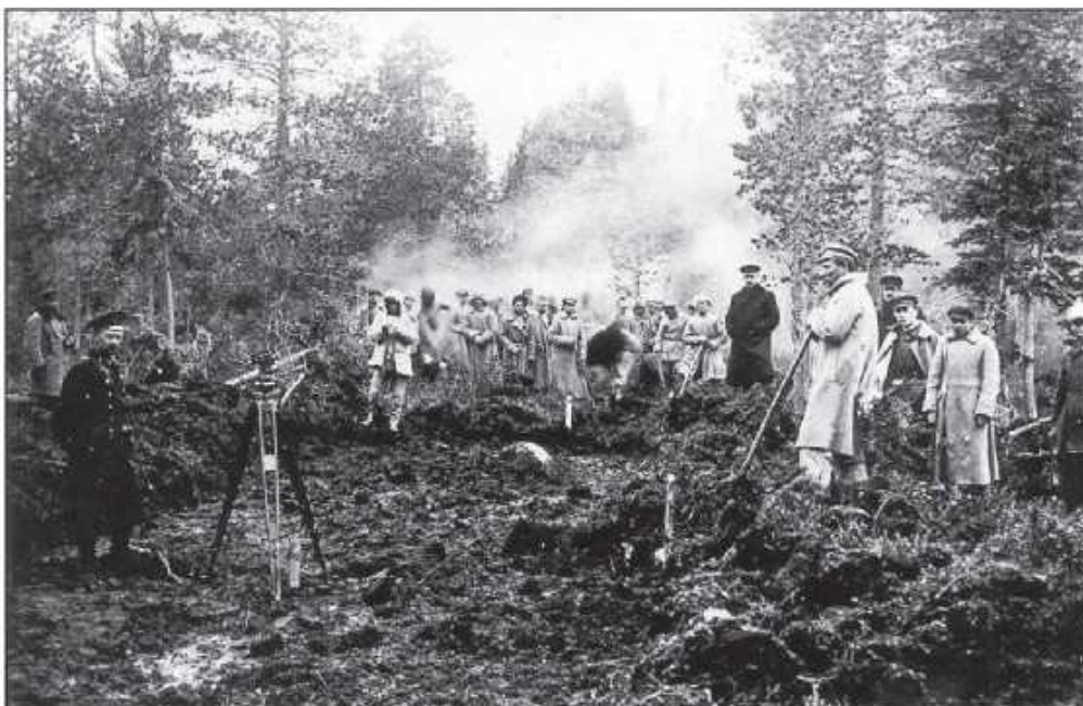
Соловецкий концлагерь. Строительство узкоколейки
