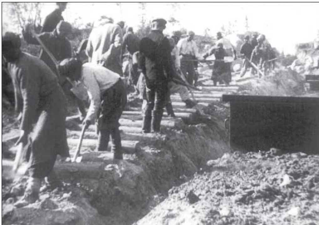
Соловецкий концлагерь. Строительство узкоколейки
