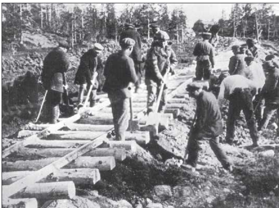
Соловецкий концлагерь. Строительство узкоколейки
