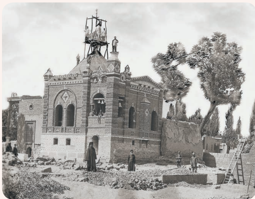
Строительство храма в Урмии
