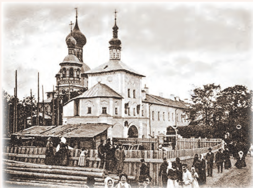
Общий вид Николо-Перервинского монастыря и место постройки нового храма
