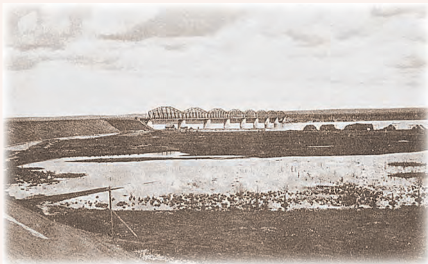
Мост через реку Каму
