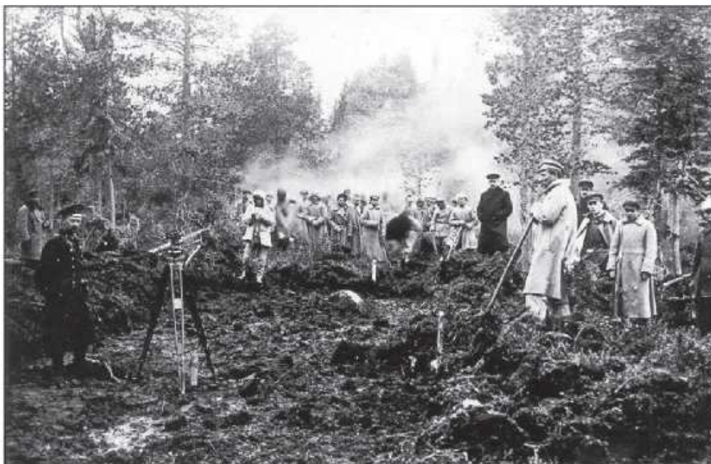
Соловецкий концлагерь. Строительство узкоколейки
