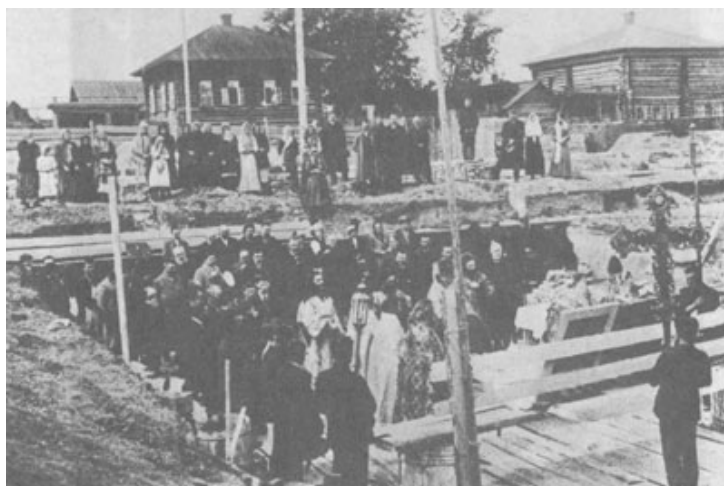
Закладка больницы в городе Чердыни
